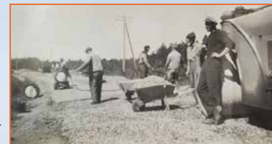
Albækkere funderer og tromler inden betonlaget lægges.
