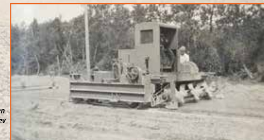
En mere effektiv betonblander udlånt af Colas er her hævet op på jernbanesveller.
