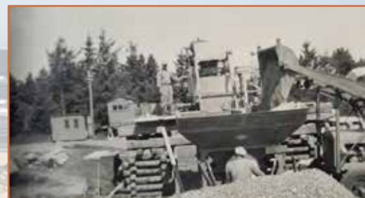
En mere effektiv betonblander udlånt af Colas er her hævet op på jernbanesveller.
